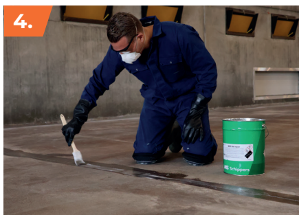
De randen van de scheur voorzien van MS Primecoat-trans 24u drogen
