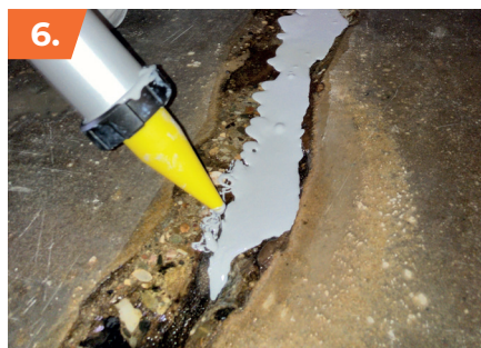
Elastische voegkit aanbrengen in de scheur
