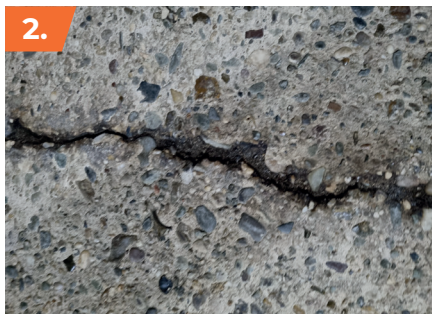
Afgebrokkeld beton verwijderen
