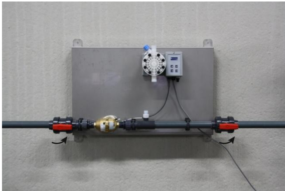
Afbeelding 1: Opendraaien kogelkranen
