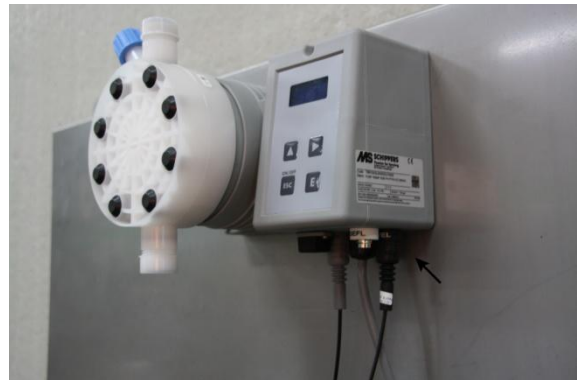
Afbeelding 2: Aansluiten droogloopbeveiliging
