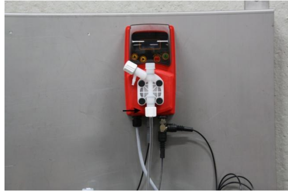
Afbeelding 6: Aansluiten aanzuigslang
