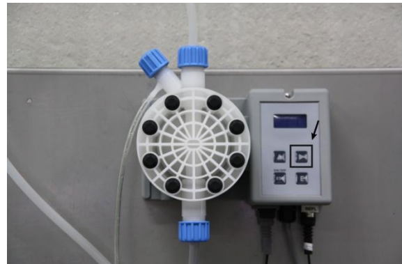
Afbeelding 16: Persleiding vullen
