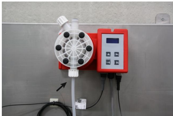
Afbeelding 7: Aansluiten aanzuigslang
