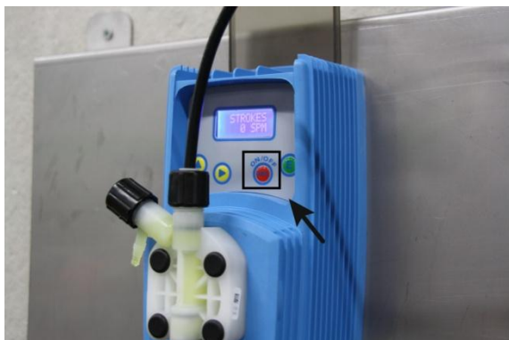
Afbeelding 9: Aanzetten van de pomp
