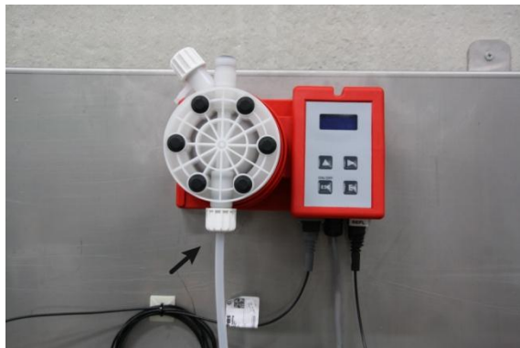
Afbeelding 7: Aansluiten aanzuigslang
