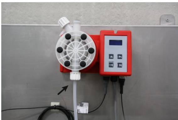
Afbeelding 3: Aansluiten aanzuigslang
