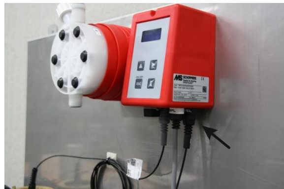
Afbeelding 2: Aansluiten droogloopbeveiliging
