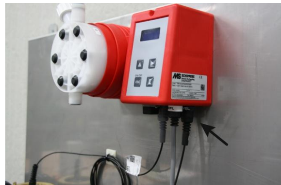
Afbeelding 2: Aansluiten droogloopbeveiliging
