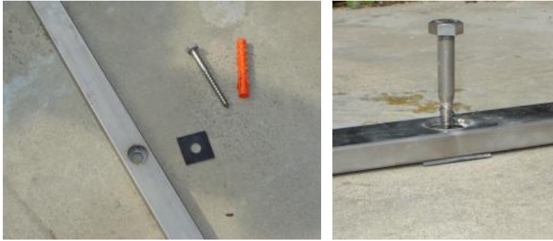
(Gewindebolzen M10x100 + Gummi + Dübel diam 14x90)
